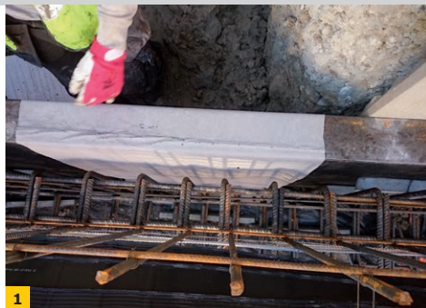
FOT. 1–2. Montaż maty penetrującej; fot. Hydrostop
