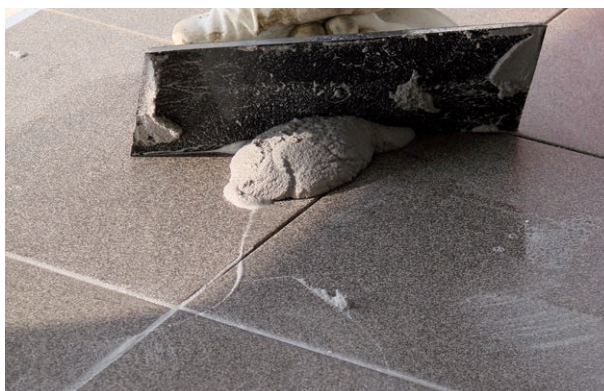
FOT. 6. Spoinowanie powierzchni za pomocą wielofunkcyjnej zaprawy do spoin MULTIFUGE® Base
