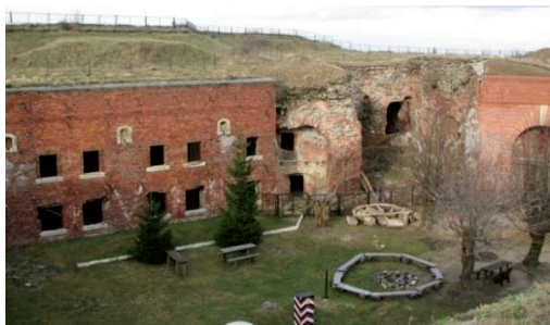
FOT. 1. Przykład historycznego dachu zielonego w formie w Srebrnej Górze; fot.: Z. Matkowski
