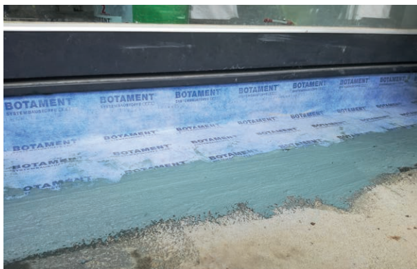
FOT. 4. Wklejenie samoprzylepnej taśmy uszczelniającej BOTAMENT® PB Portalband
