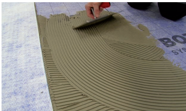
FOT. 5. Nakładanie rozplývnej zaprawy klejowej BOTAMENT® M 29 lub BOTAMENT® M 29 HP. Przystąpienie do klejenia płytek
