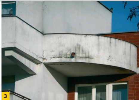
FOT. 2-3. Skutki niedoróbek i ignorancji przy wykonywaniu uszczelnień balkonów z zabudowaną balustradą; fot.: M. Rokiel
