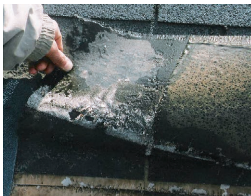
FOT. 2. Widok lodu na dolnej powierzchni pokrycia dachowego; fot.: Z. Matkowski
