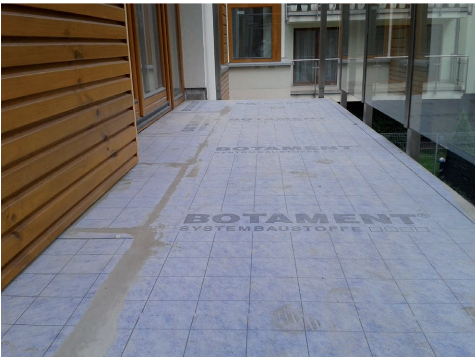
FOT. 7. Hydroizolacja balkonu z wykorzystaniem maty uszczelniająco-kompensującej BOTAMENT® AE
