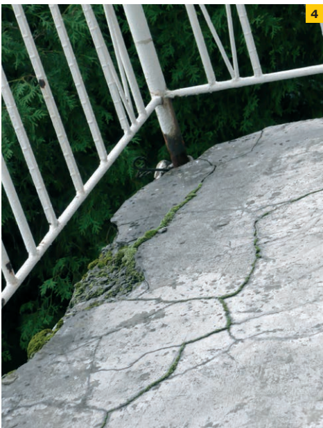
FOT. 2-3. Skutki niedoróbek i ignorancji przy wykonywaniu uszczelnień balkonów z zabudowaną balustradą; fot.: M. Rokiel
