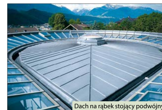
Dach ułożony na rąbek kątowy
