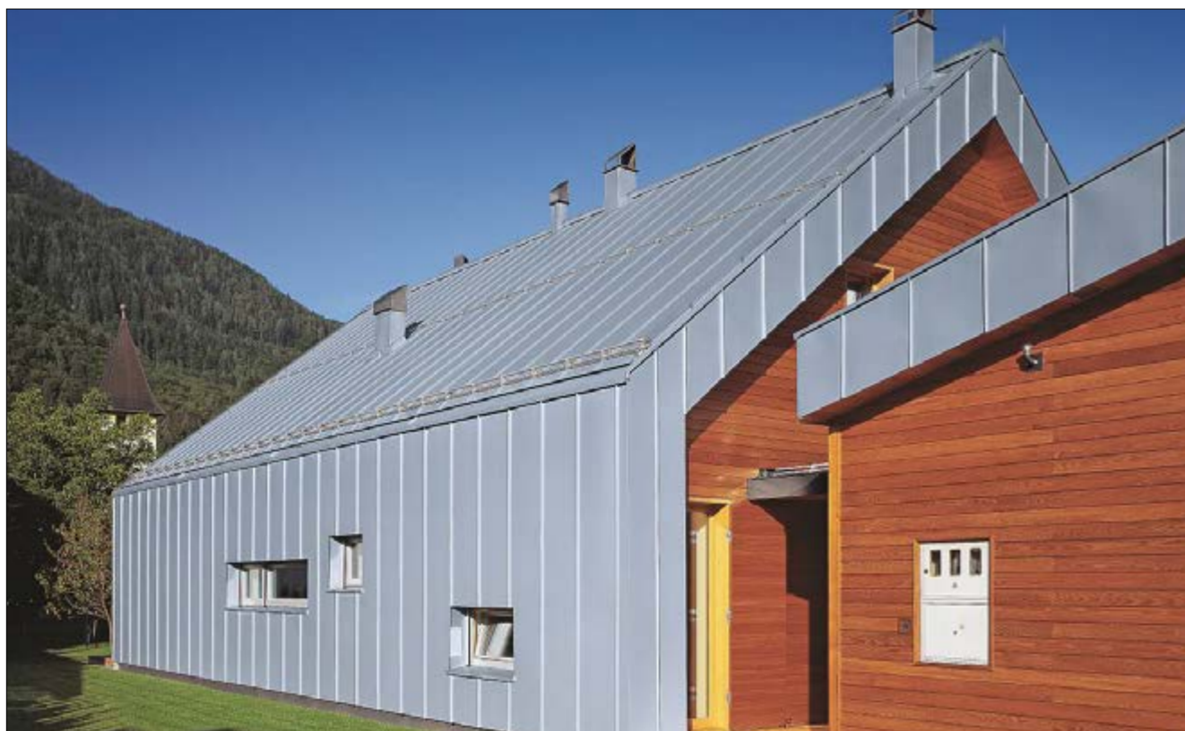
Pokrycie z blachy cynkowo-tytanowej
