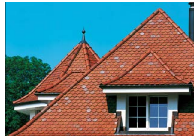
Dach pokryty klasyczną dachówką ceramiczną – karpówką
