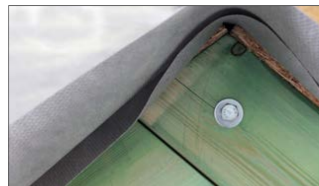
Montaż membrany dachowej mdm® Ventia
