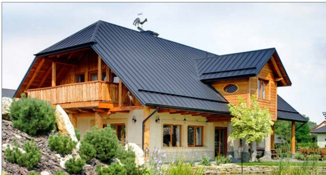
Dach pokryty blachą na rąbek stojący
