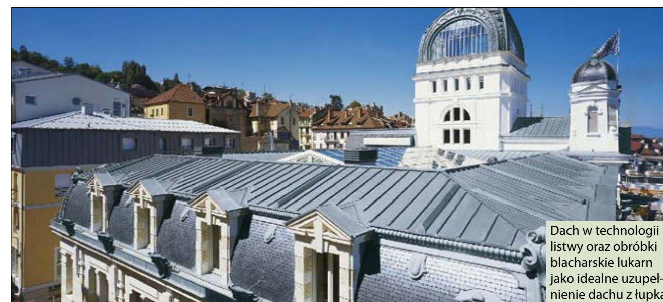
Dach ułożony na rąbek kątowy
