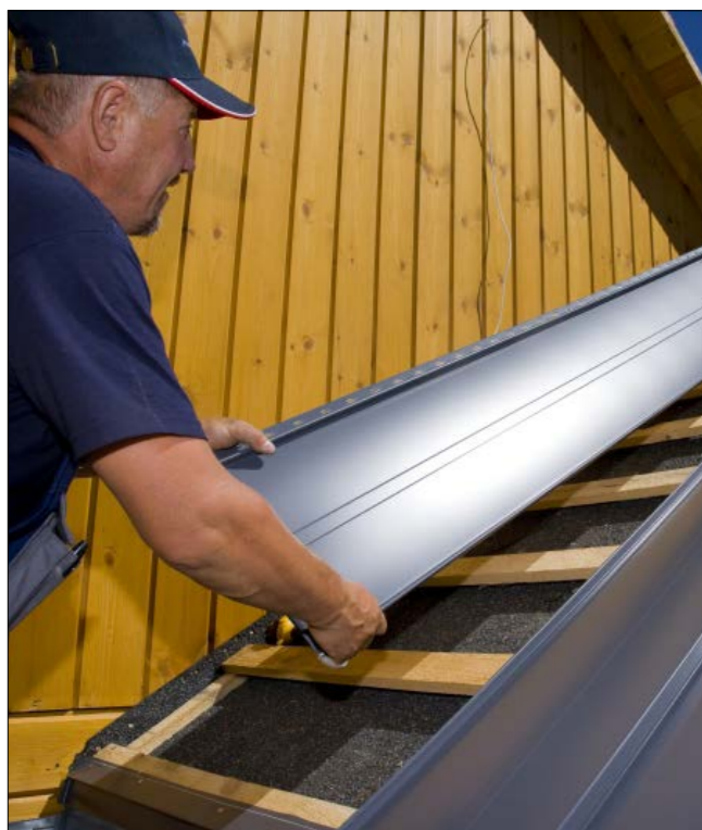
Układanie blachy na rąbek stojący
