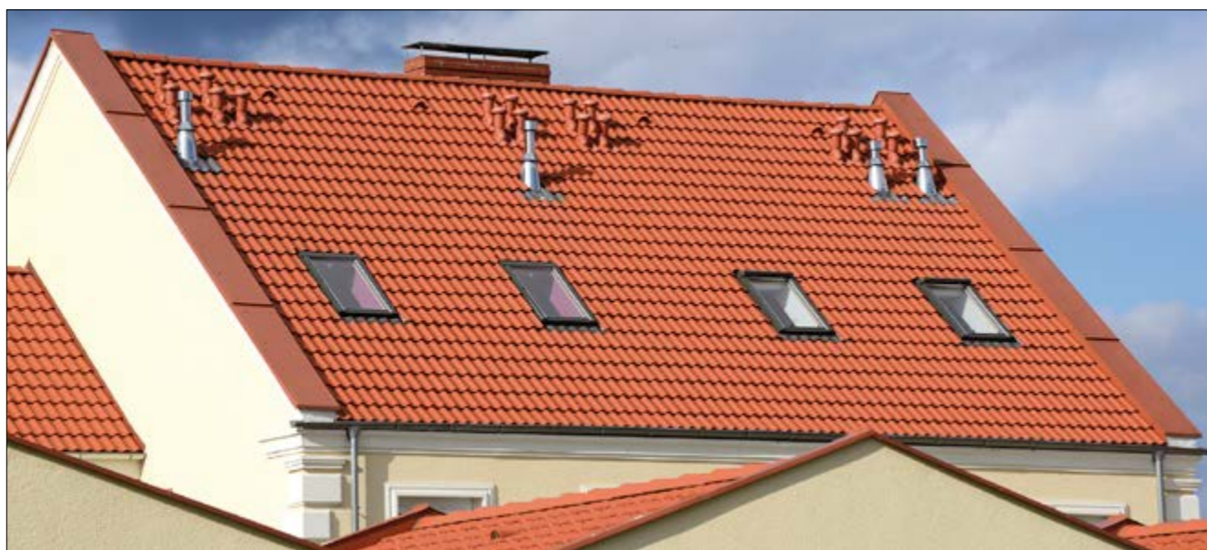
Dach pokryty dachówką cementową
