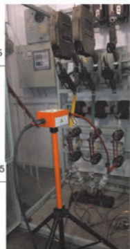
Rys. 8. Zestawienie wyników pomiarów tg δ, rezystancji i pojemności kabla dla różnych wartości napięć probierczych VLF 0,1 Sin oraz widok przyłączonego układu probierczego
