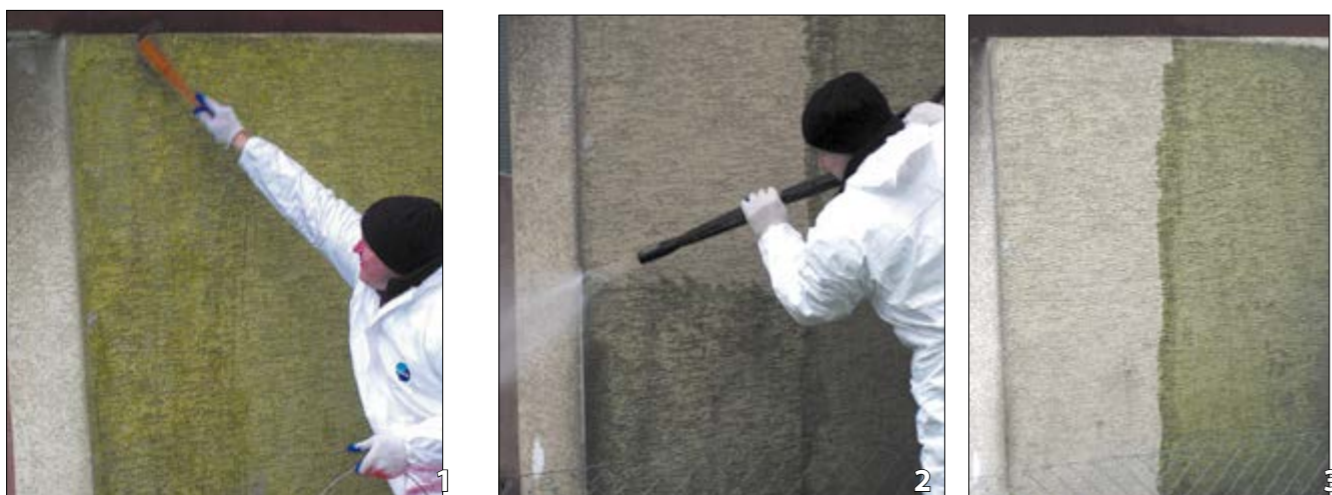
Czyszczenie mechaniczne ocieplonej elewacji zasiedlonej glonami: 1 – wstępne mycie elewacji i/lub nakładanie środka do sanityzacji; 2 – mycie elewacji pod ciśnieniem; 3 – efekt czyszczenia – po lewej stronie część ściany po zabiegach, po prawej – część nieoczyszczona Fot. archiwum SSO
