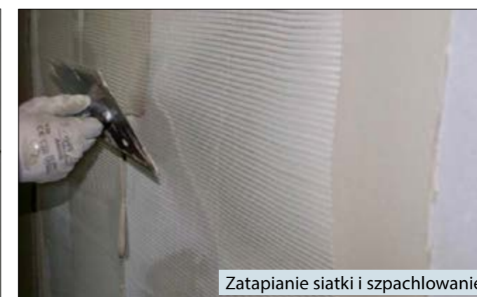
Rozprowadzanie kleju na ścianie
